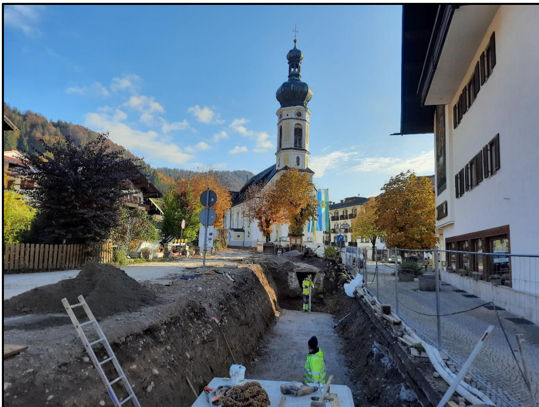
Abb.: Bauabschnitt Hausbachweg
