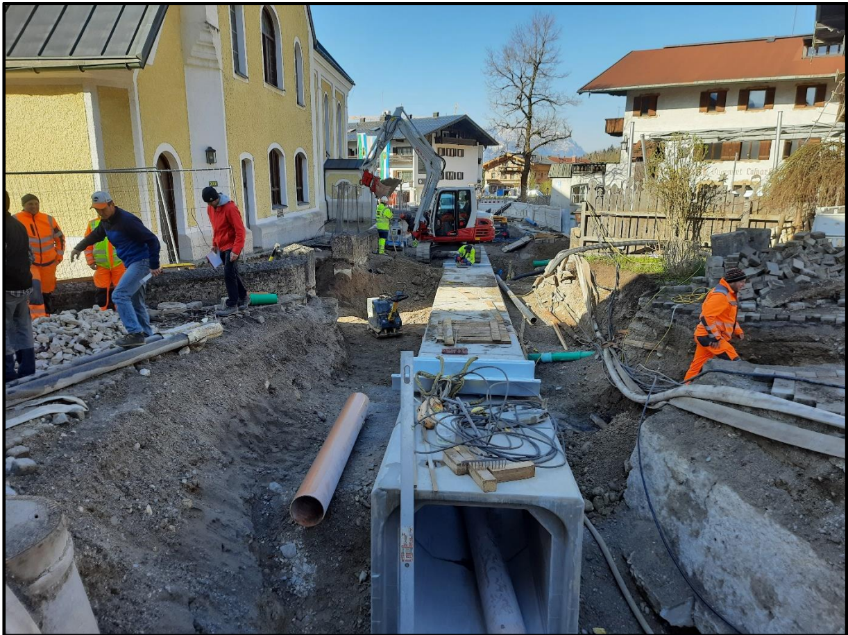
Foto: Stand der Baustelle hinter der Kirche
