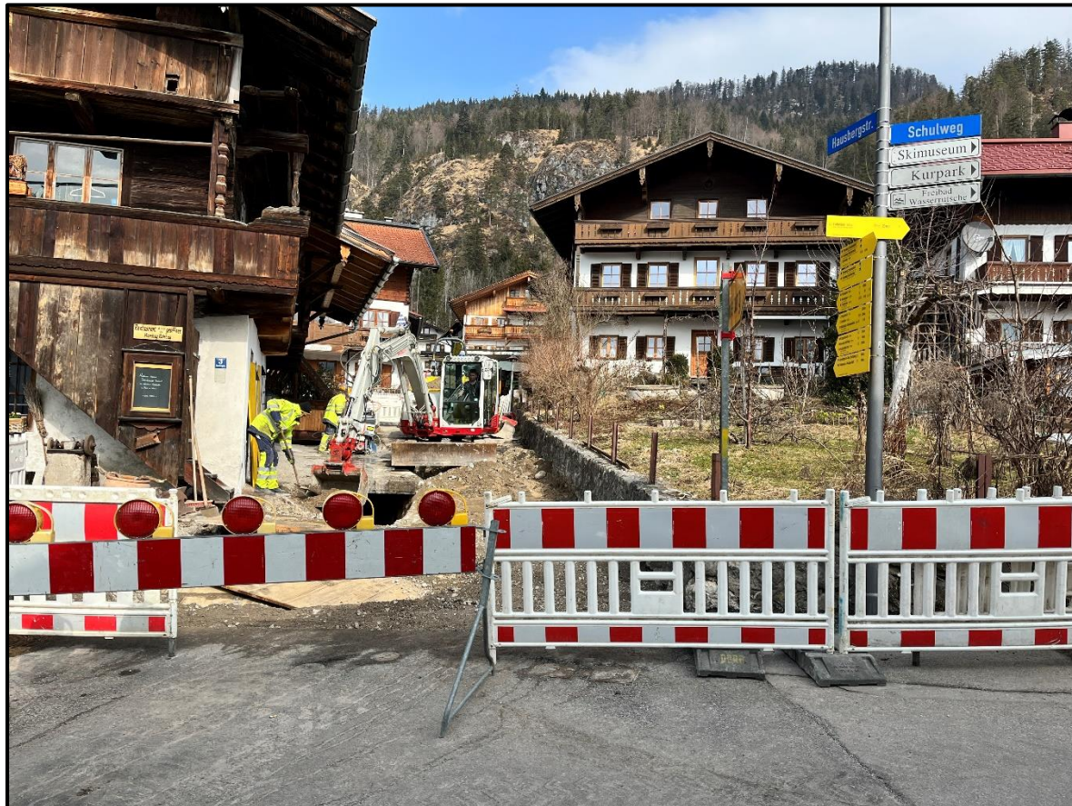
Foto: Beginn der Bauarbeiten Abschnitt obere Hausbergstraße
