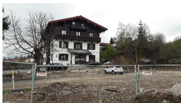
Abb. 2 Tiroler Straße 34 Blickrichtung Westen
