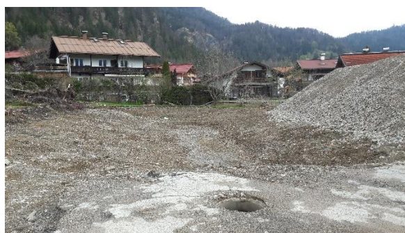
Abb. 4 Ahornstraße 5 und 3a Blickrichtung Nordosten
