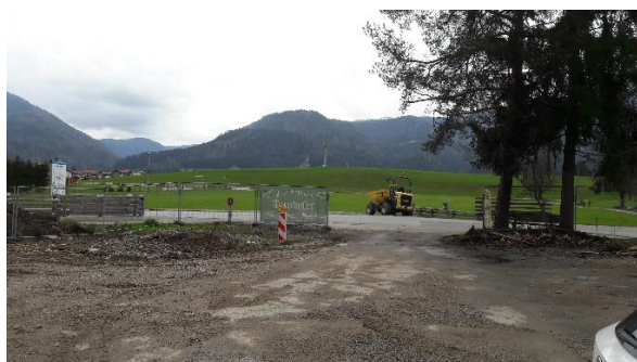
Abb. 1 Ein- und Ausfahrt Flur-Nr. 109/3 Blickrichtung Südosten
